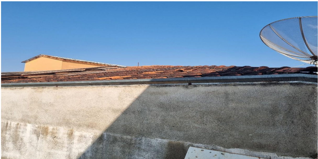
Figura 4 – Vista Lateral esquerda Posto de Saúde – Telhado
