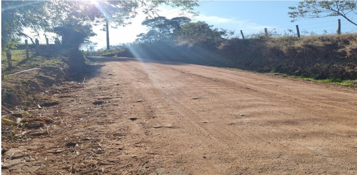
Figura 1 – Início no calçamento existente (Casa Jesus)
