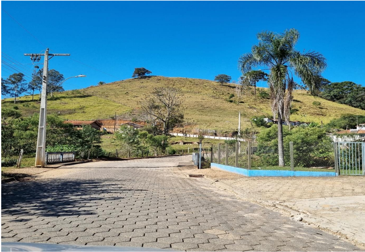
Figura 5 – Final (Ponte na saída para Borda da Mata)
