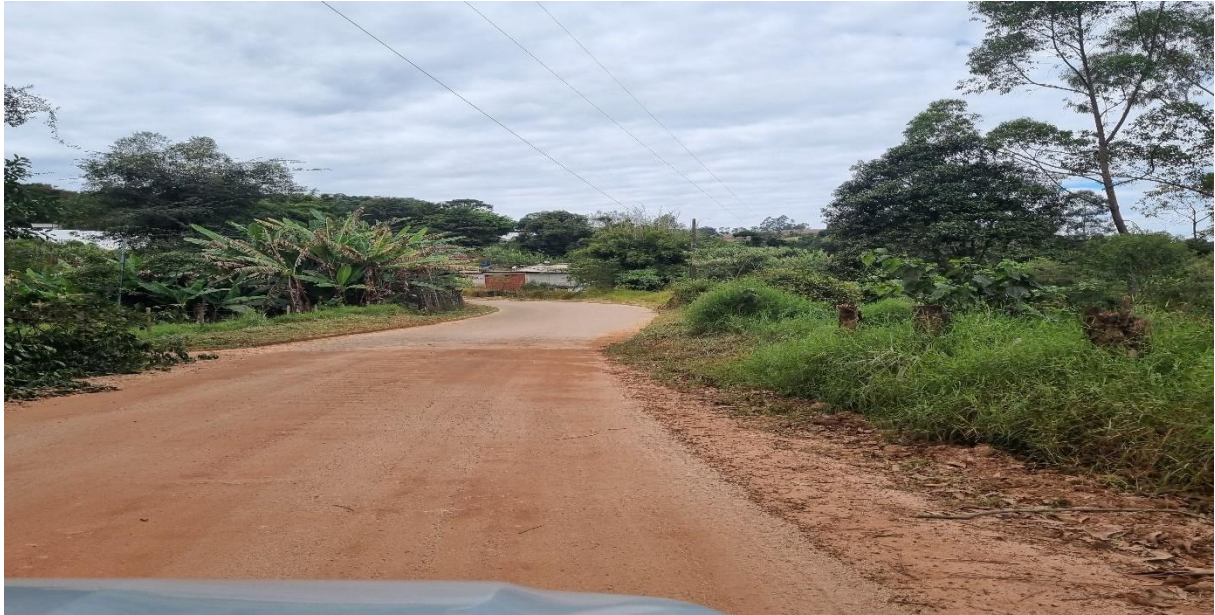
Figura 4 – Final (Casa Sr. Ailton)
