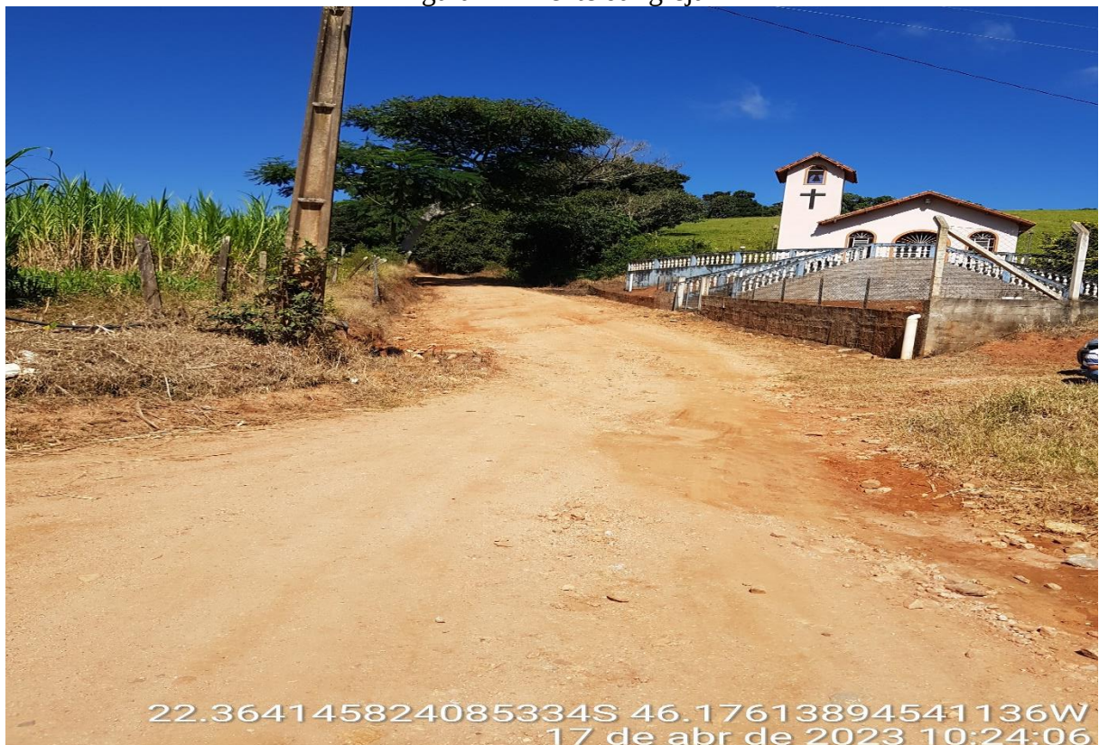
Figura 3 – Final no fundo da Igreja
