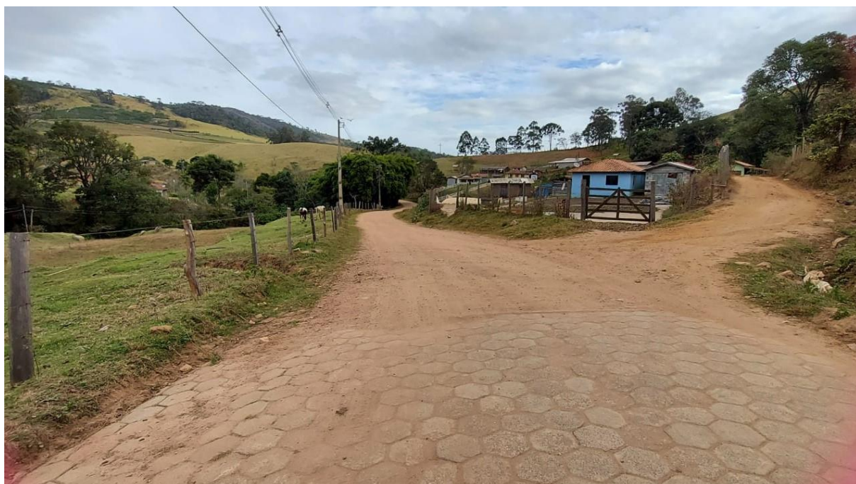
Imagens 5 e 6 - Trecho 3: Estrada Vicinal Pedra Negra (Depois da praça do bairro)
